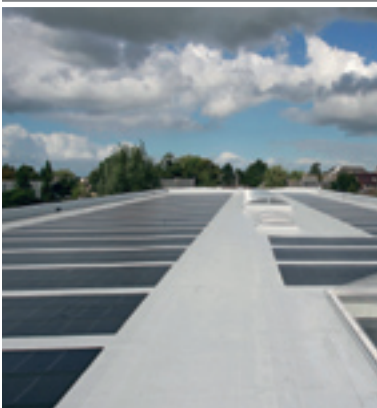
▲ Installatiebedrijf Wemmers, Bleskensgraaf
